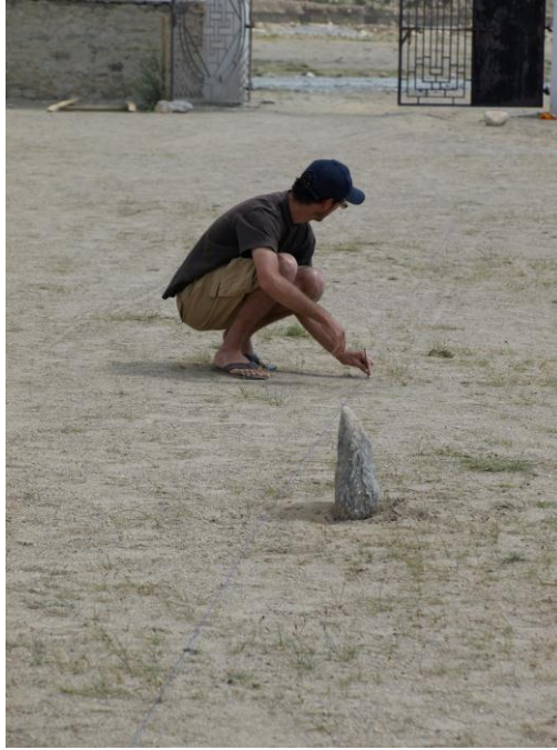
Figure 7 NBP - traçage au sol des bâtiments
