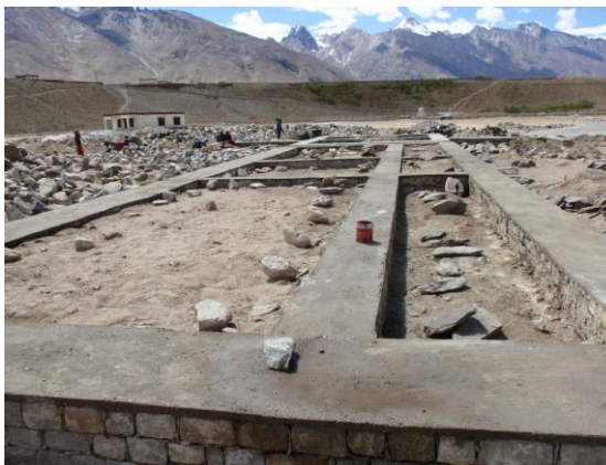
Figure 23 : NBP : DPC sur le 1 er bâtiment
