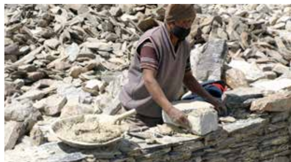
Costruzione della muratura in pietra nera
