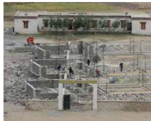
Cantiere a fine agosto 2012
