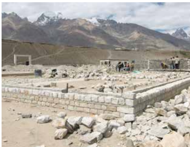
Fondamenta di granito per l'edificio delle aule di corso
