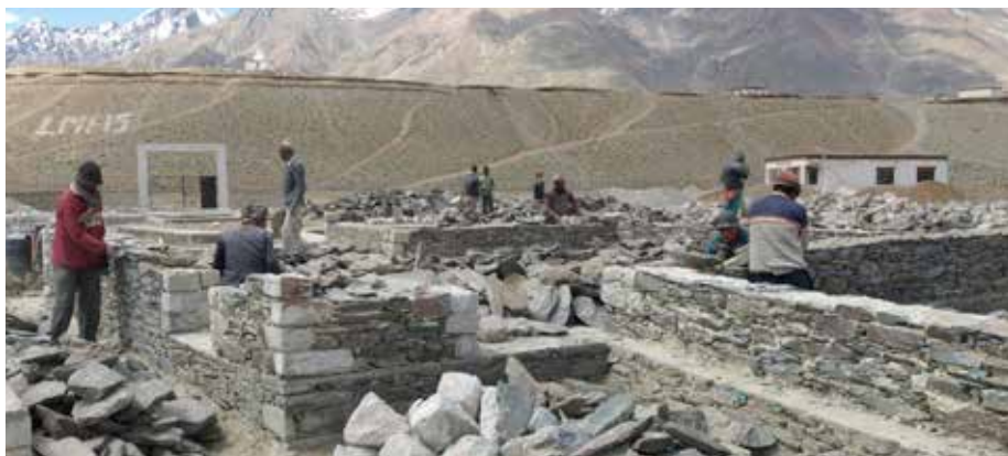
Cantiere a fine luglio 2012
