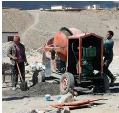
Betoniera utilizzata per la colatura dei pilastri
