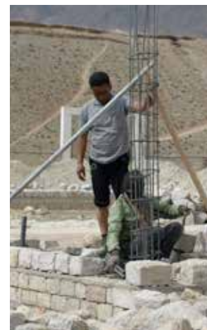
Posa dei cavi in metallo per i pilastri verticali
