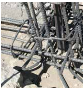
Dettaglio del collegamento tra i cavi verticali e orizzontali
