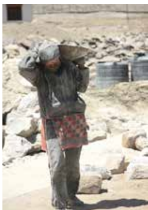
Trasporto del calcestruzzo
