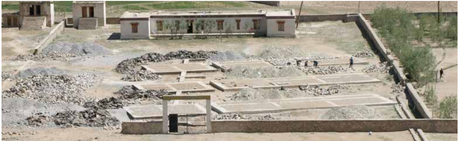
Cantiere all'inizio di luglio 2012
