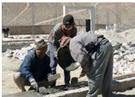
Colatura dei pilastri orizzontali
