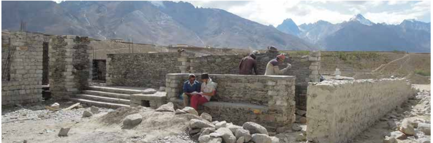
Scale e Mani Rigmo in cantiere con lastre di cemento armato sui punti di separazione
