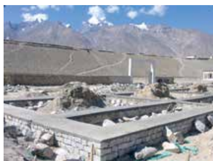
Fondamenta realizzate nel 2011
