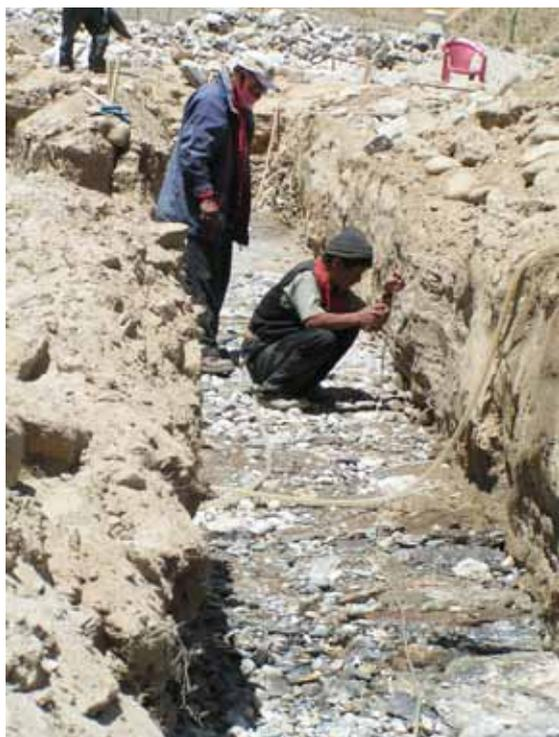
*Rafforzamento del suolo-Fase 2: bloccaggio e livellamento ad acqua*
