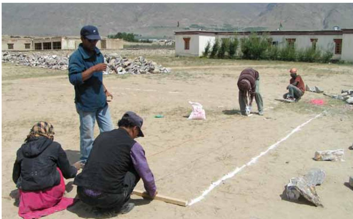
Tracciatura al suolo delle fondamenta, a cura dei capi cantiere e operai, che segue il "Center Lines" marcato prima con delle corde installate dai volontari ASF.
