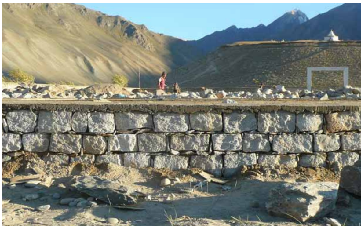
Détail de soubassement et DPC fini
