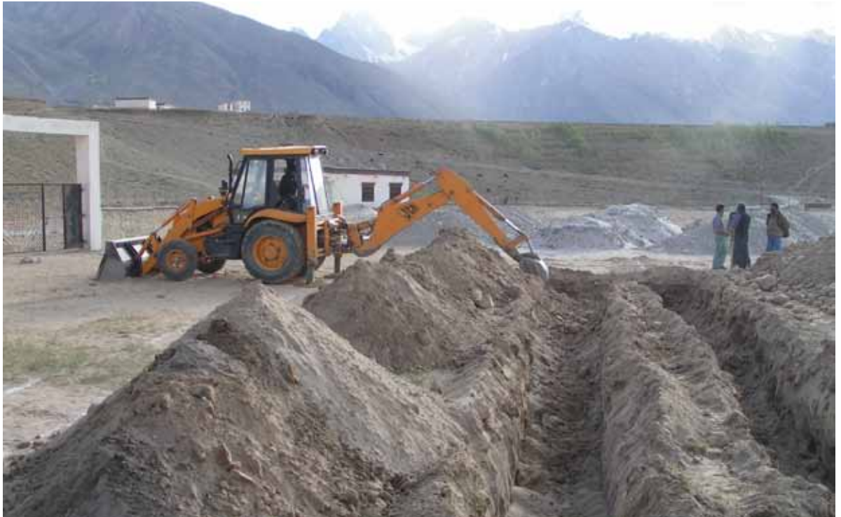
Excavation pour fondations, suivies de près aussi par une partie de professeurs de l'école LMHS
