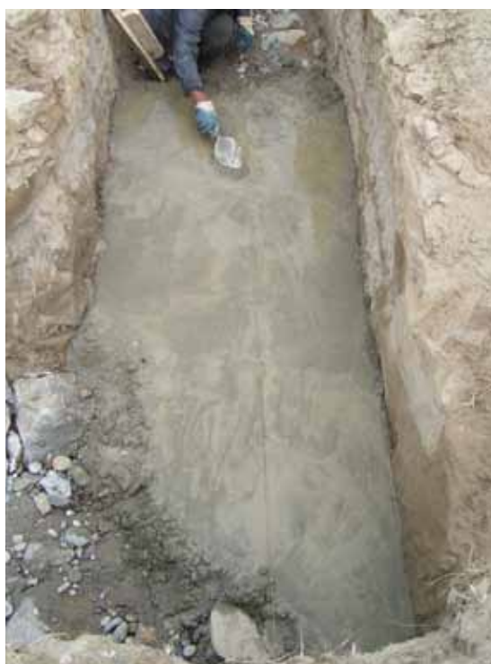
Renforcement du sol - phase 3: Coulage du béton semelle
