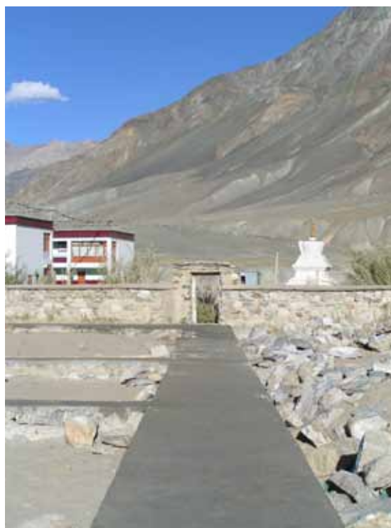
Niveau DPC fini sur soubassement de salles de cours
