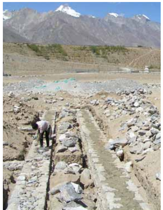
Fondations avant et après lit de mortier en terre
