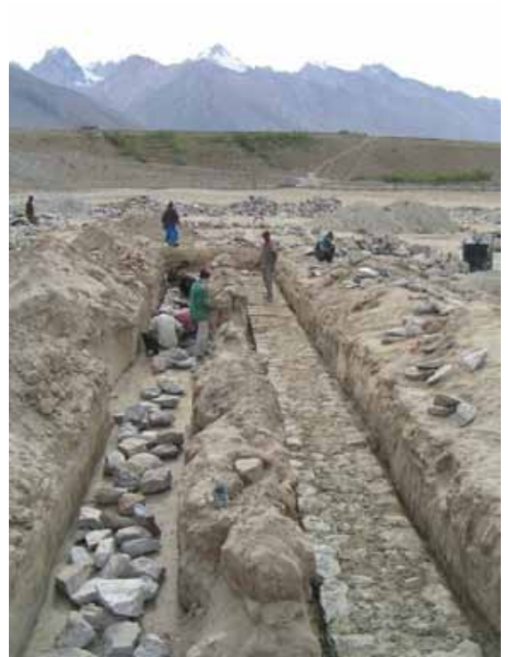
à droite un premier niveau fini et à gauche en réalisation
