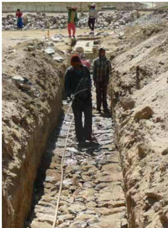
Renforcement du sol - phase 1: Lit de grands blocs pierre
