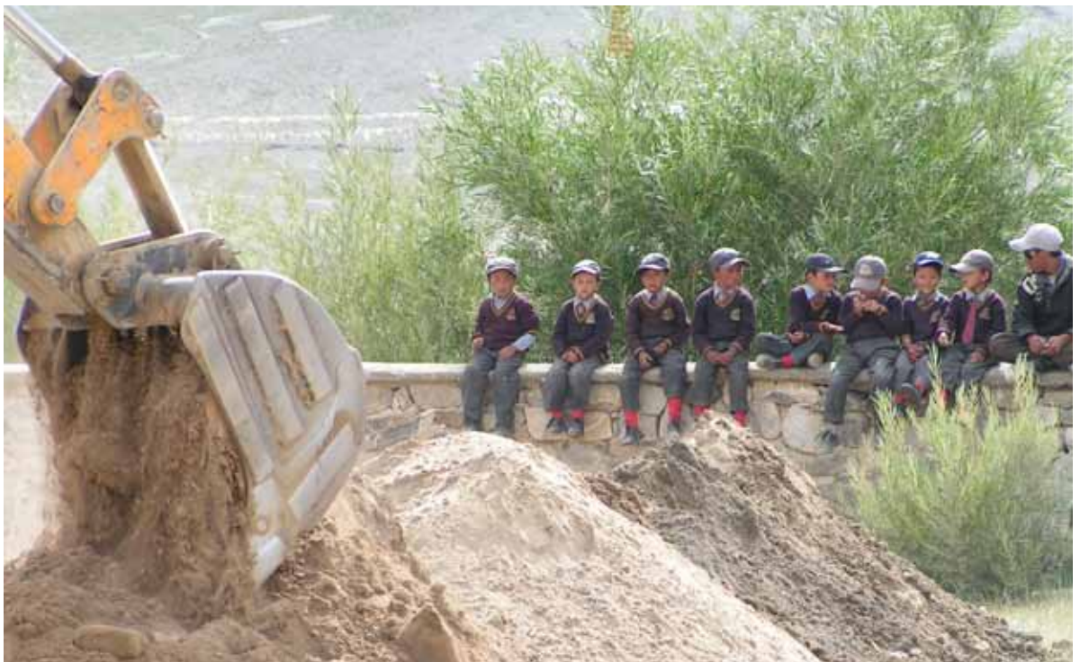
Suivi des travaux de la pelleteuse par élèves de l'école LMHS
