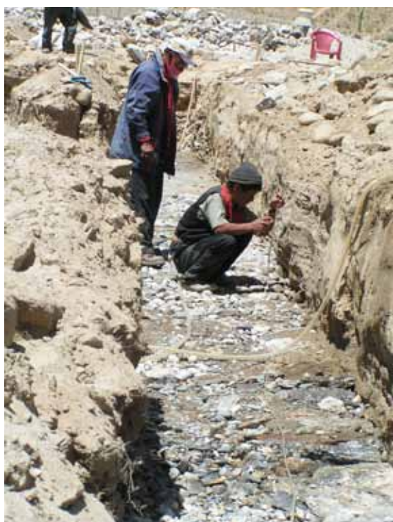
Renforcement du sol - phase 2: Blocage et Niveau à eau
