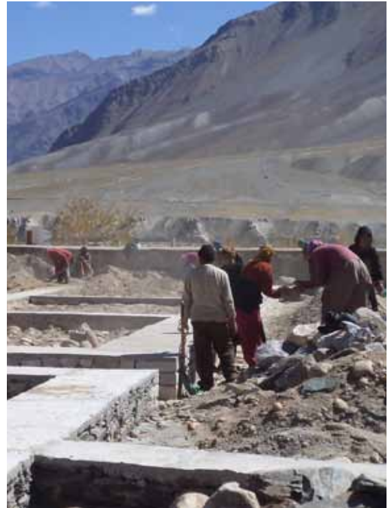
Rangement et Nettoyage du chantier par les parents
