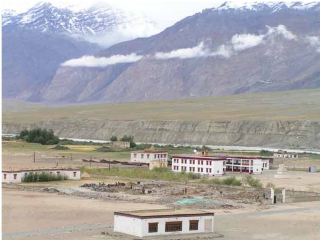
Vue du site pendant les travaux (Août 2011)
