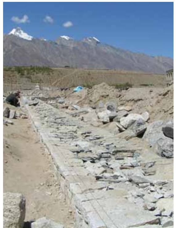
Vue générale Soubassement avec deuxième niveau fini
