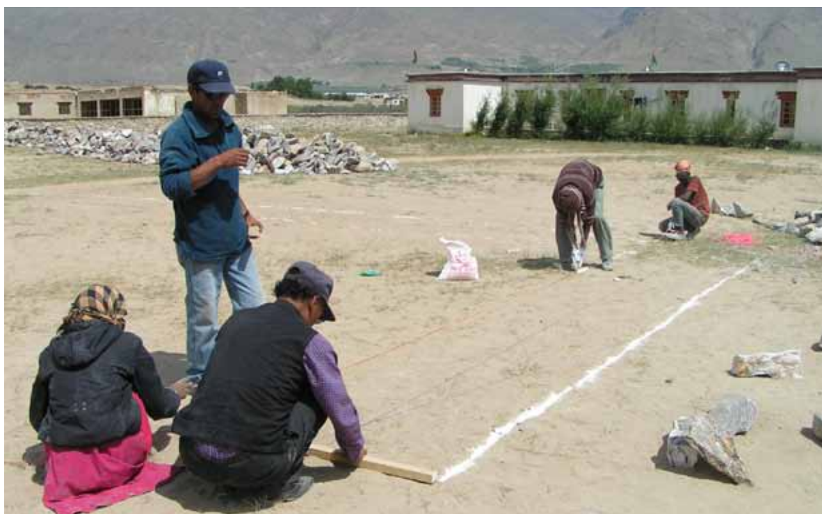
Traçage au sol des fondations, par les conducteurs de travaux et ouvriers, en suivant les Center Lines marquées préalablement avec des cordes installées par les volontaires ASF.
