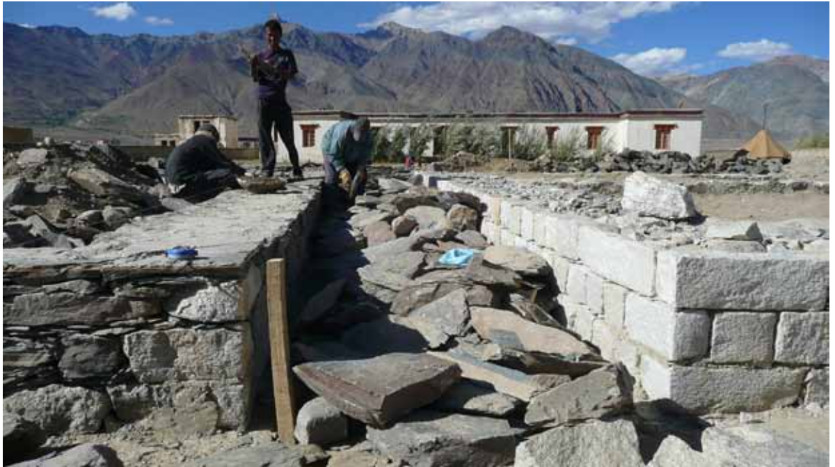
Détail d'angle de deux types de soubassement, à droite les salles de cours et à gauche les bureaux
