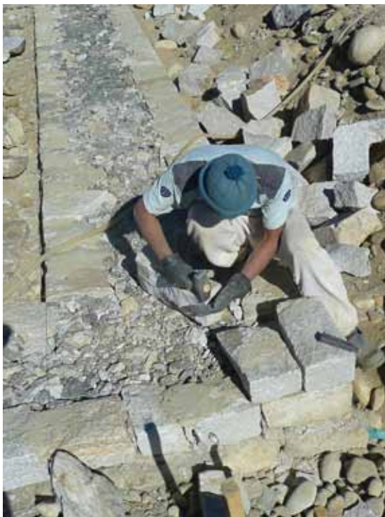
Détail Soubassement avec premier niveau fini
