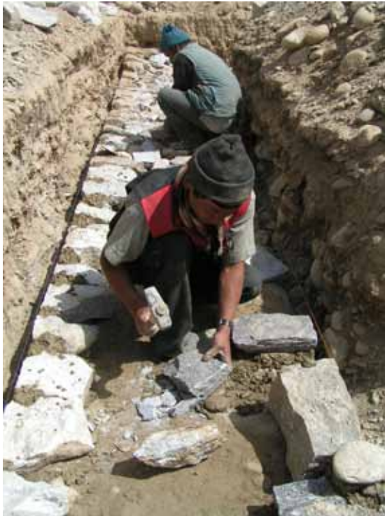
Taille de pierres et Pose de premier niveau de Fondations
