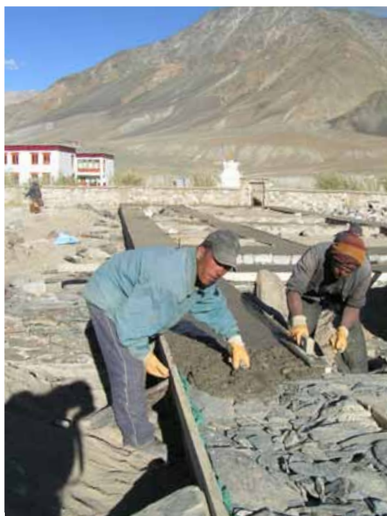
Coulage DPC en réalisation sur soubassement bureaux
