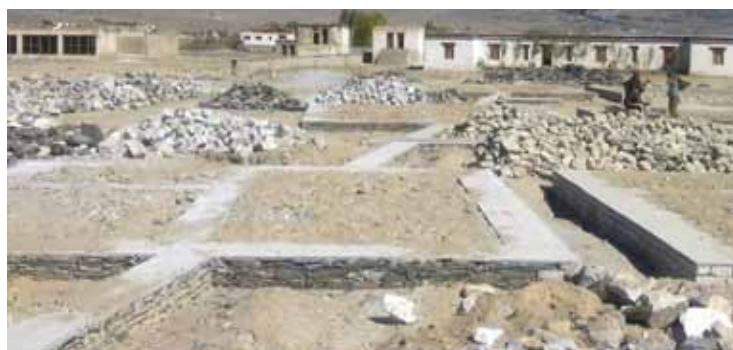
Le site pendant les travaux (en haut) et après nettoyage (en bas)
