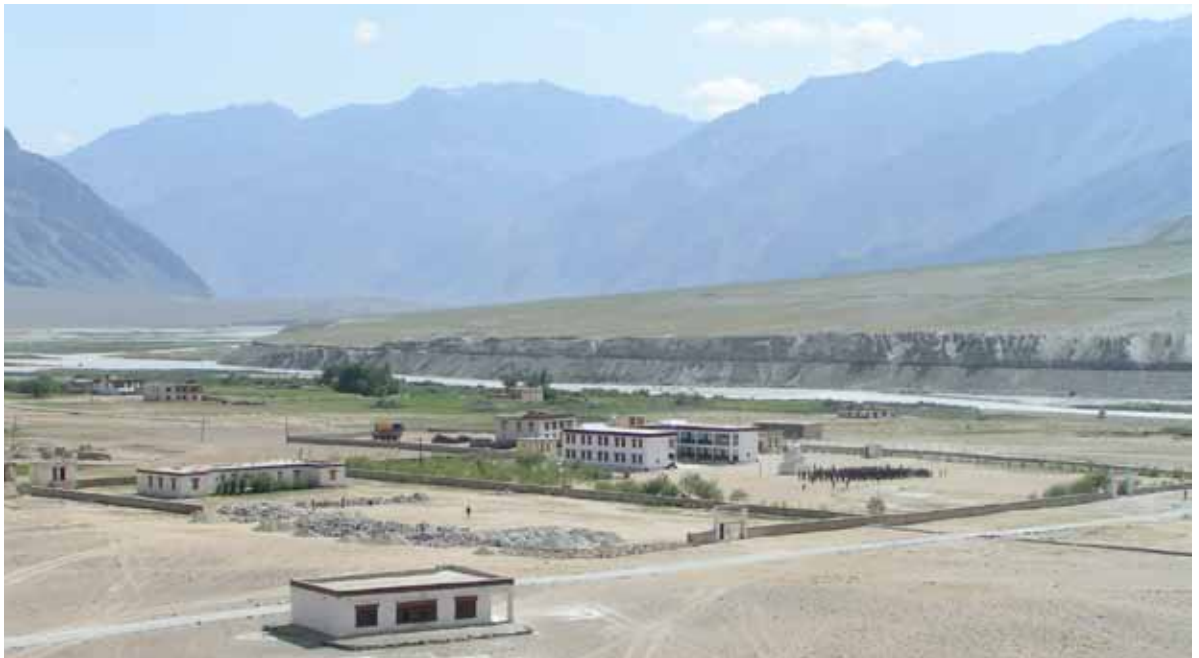
Vue du site avant démarrage des travaux (début Juillet 2011)
