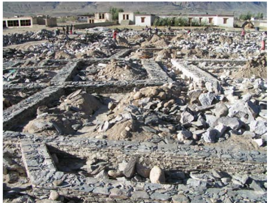
Le site pendant les travaux
