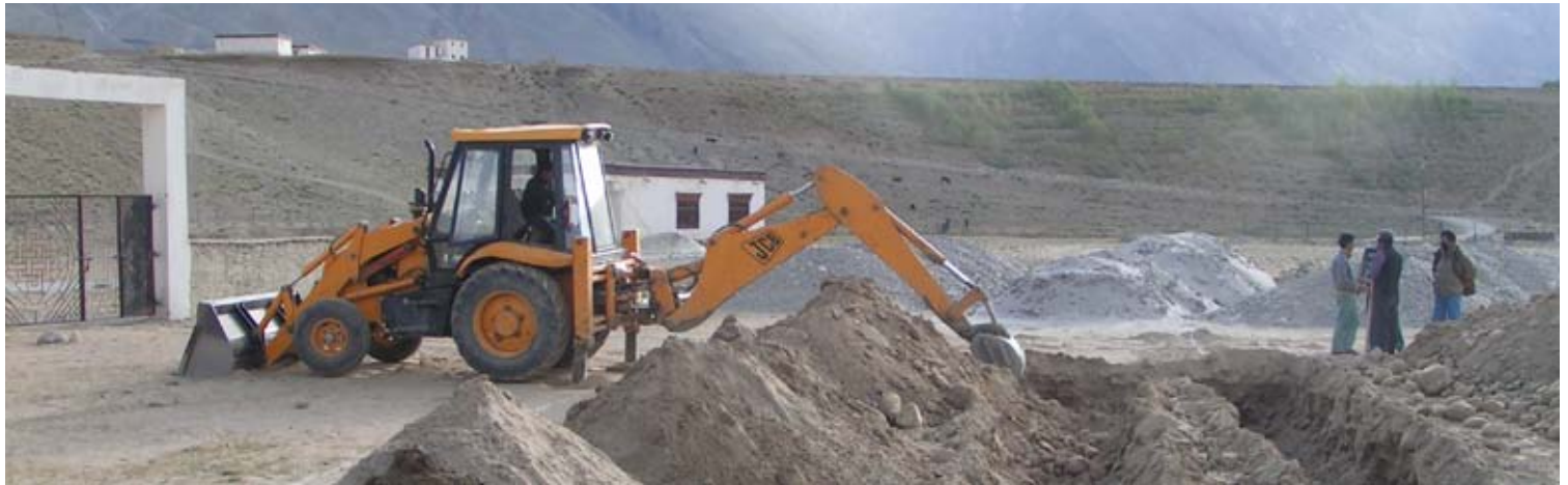
Excavation pour fondations, suivies de près aussi par une partie des professeurs de l'école LMHS
