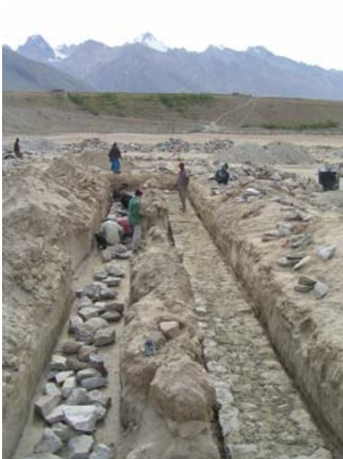
à droite premier niveau fini et à gauche en réalisation
