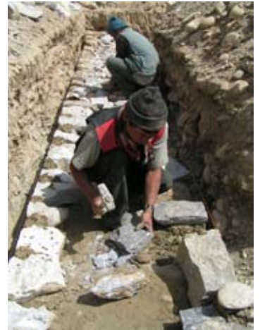
Taille de pierres et pose du premier niveau de fondations
