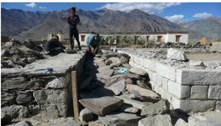
Détail d'angle de deux types de soubassement, à droite les salles de cours et à gauche les bureaux
