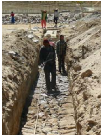
Renforcement du sol - phase 1: Lit de grands blocs de pierre
