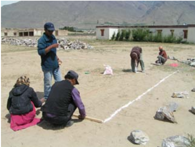
Traçage au sol des fondations, par les conducteurs de travaux et ouvriers, en suivant les Center Lines marquées préalablement avec des cordes installées par les volontaires ASF.
